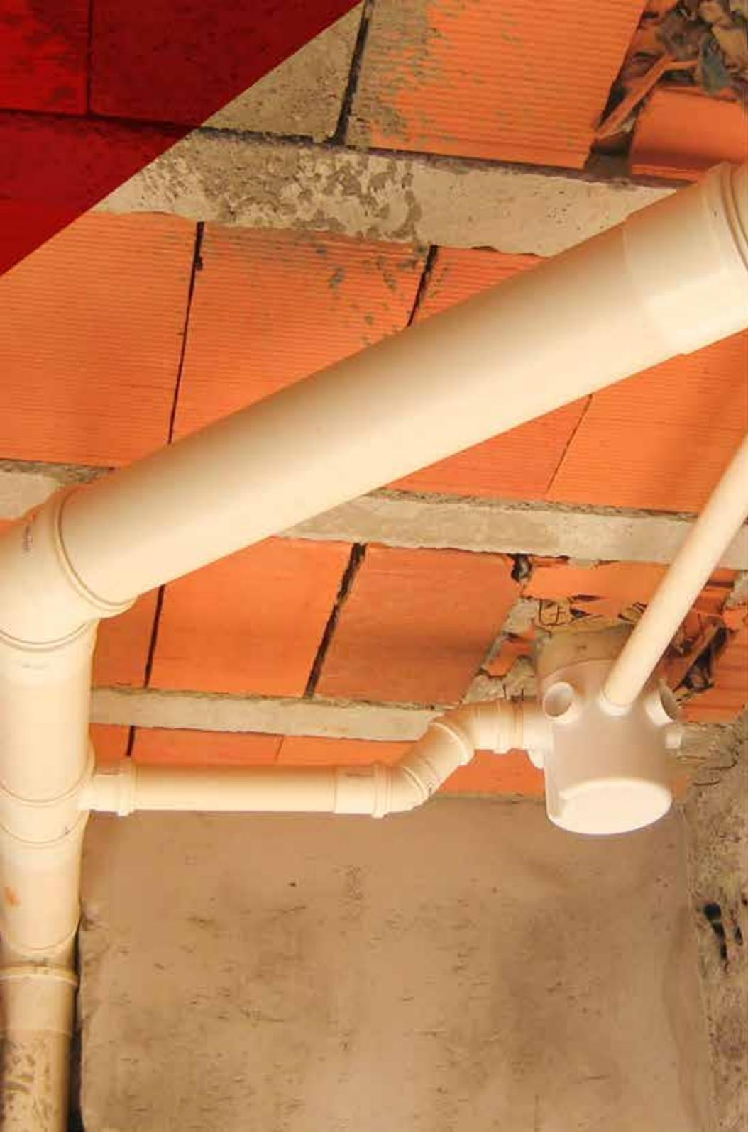
O CONTRATANTE precisa deixar um ponto de água para prosseguir com a tubulação na casa, as tubulações utilizadas são de 25mm. É instalado uma caixa de 500 litros, deixando todas as tubulações com pontos de água fria. Em relação ao esgoto, o CONTRATANTE precisa deixar um ponto de esgoto, para que seja realizada a inserção da tubulação da casa.
