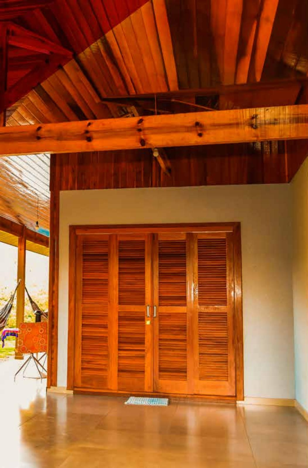
A pintura de uma casa de madeira é de grande importância como as outras etapas da obra. Em nossas obras passamos três de mãos de verniz nas madeiras, assim criando uma película impermeabilizante, proporcionando uma maior durabilidade a madeira. Nas paredes de alvenaria é utilizado tinta à base de água (tinta acrílica).
