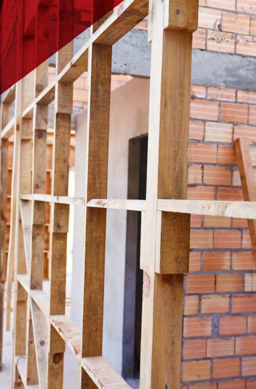
Fazemos toda a estrutura de base da casa em alvenaria (laje estrutural), após trabalhamos com as estruturas de madeira quadradas, que é distribuída a cada 50 cm uma da outra, essa estrutura fica dentro das paredes de rodeio externo e interno.
