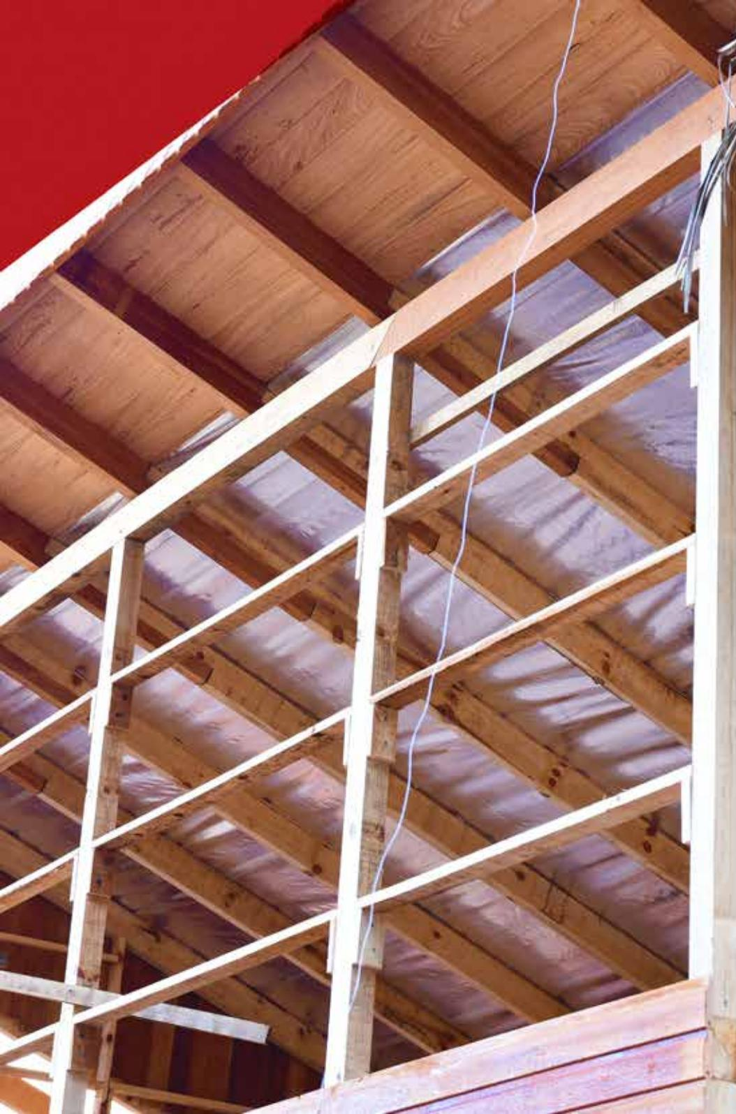
Trabalhamos com madeira nas estruturas e usamos telhas e cerâmica esmaltada (sendo as cores e modelos escolhidos pelos clientes). Fazemos a instalação de manta térmica dupla face em toda a casa.
